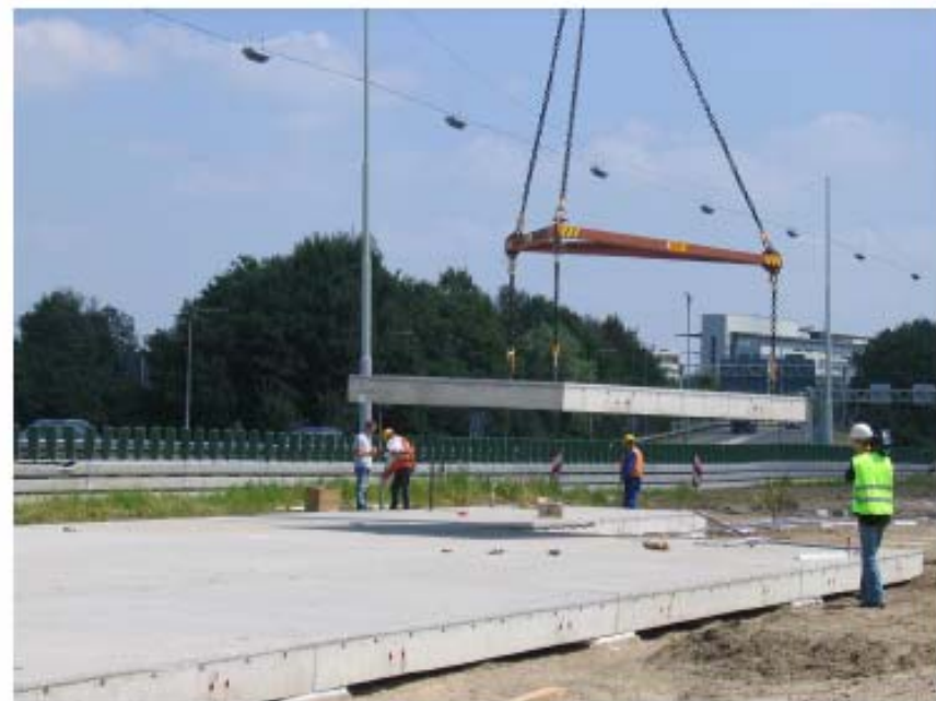
(d) Installation of concrete slab on top of
